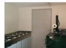
Χώρος ταξινόμησης και πλύσης (slots) σε 12 θυρίδες διαλογής για κάθε υπο-κατηγορία ανακυκλώσιμων υλικών
