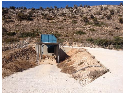
Εικόνα 2. Χώρος προσωρινής αποθήκευσης ΑΥ (πρώην ΧΑΔΑ)
